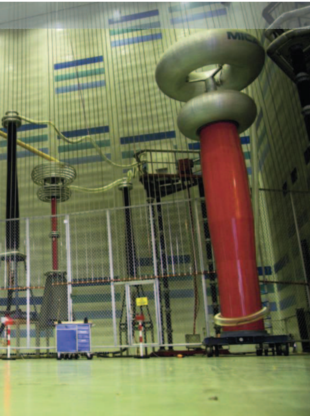
TESTUTSTYR: Komplett oppsett for kvalifisering av likepenningssystem. Kabel, skjøt og endetermineringer. FOTO: MONA SPRENGER
